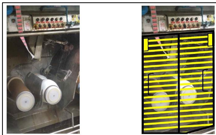
Figura 36- Posição produtora com vista dos coletores das enroladeiras e a proteção mecânica projetada para adequação à NR12.
